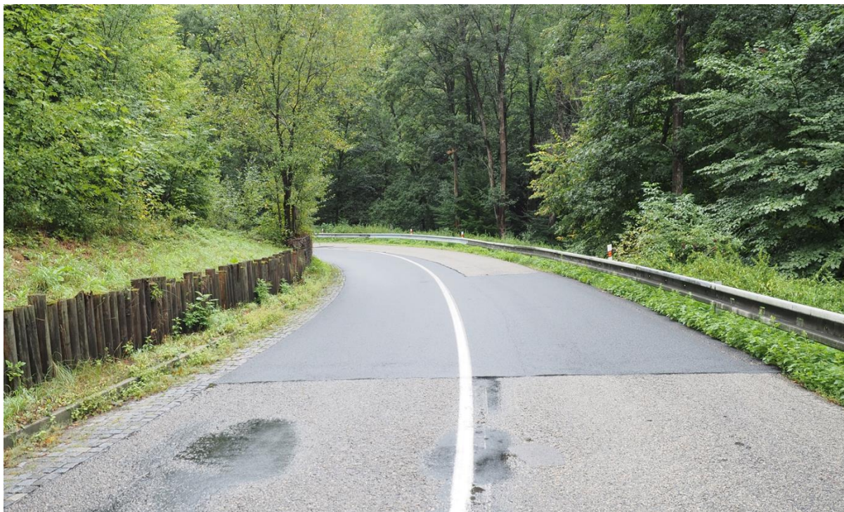
Úsek silnice II/384 u hradu Veveří
