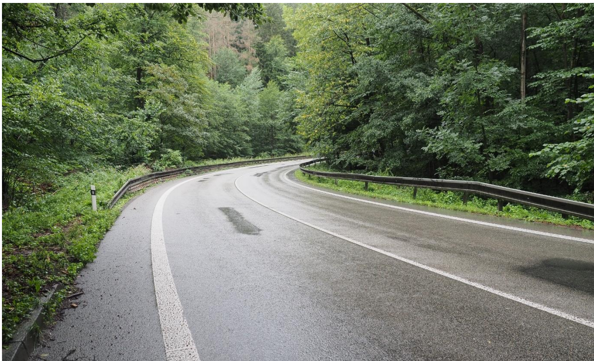
Úsek silnice II/379 u obce Šebrov
