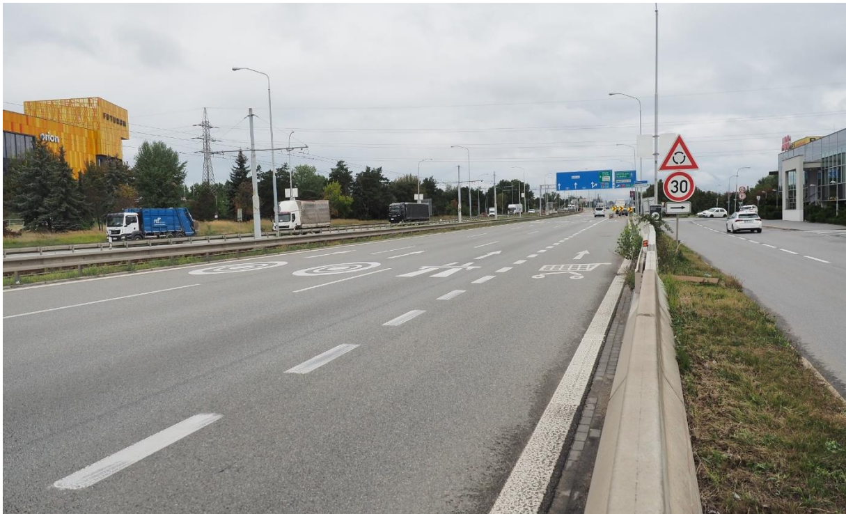
Sjezd ze silnice I/52 k OC Futurum
