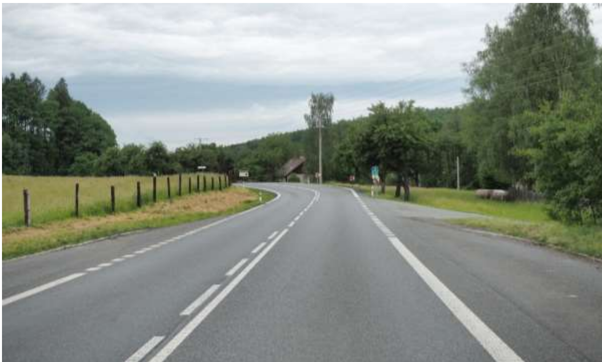
Křižovatka silnic I/20 a III/11747 u obce Klášter
