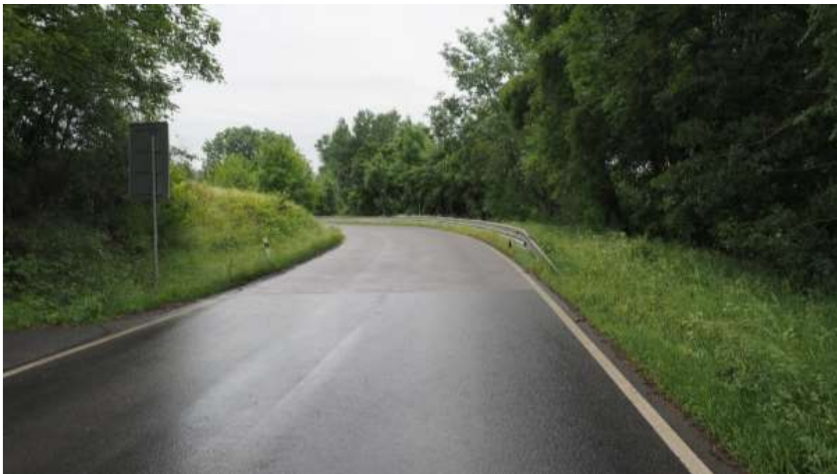
Úsek silnice III/19524 u Pařezova
