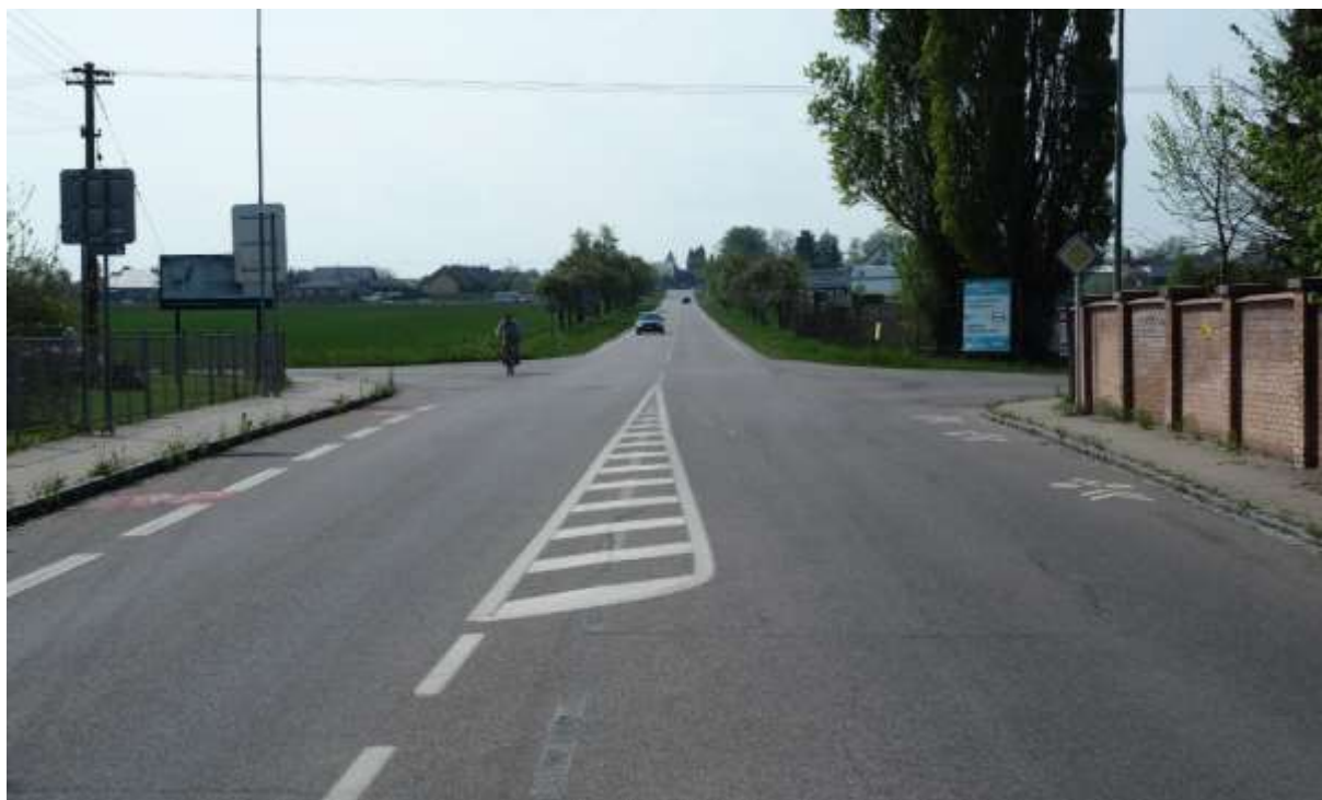
Křižovatka na II/324 v Dražkovicích
