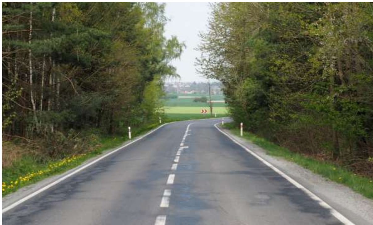
Úsek silnice II/358 u Hroubovic
