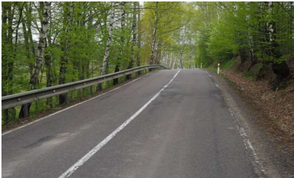
Úsek silnice na II/360 u Lanšperku
