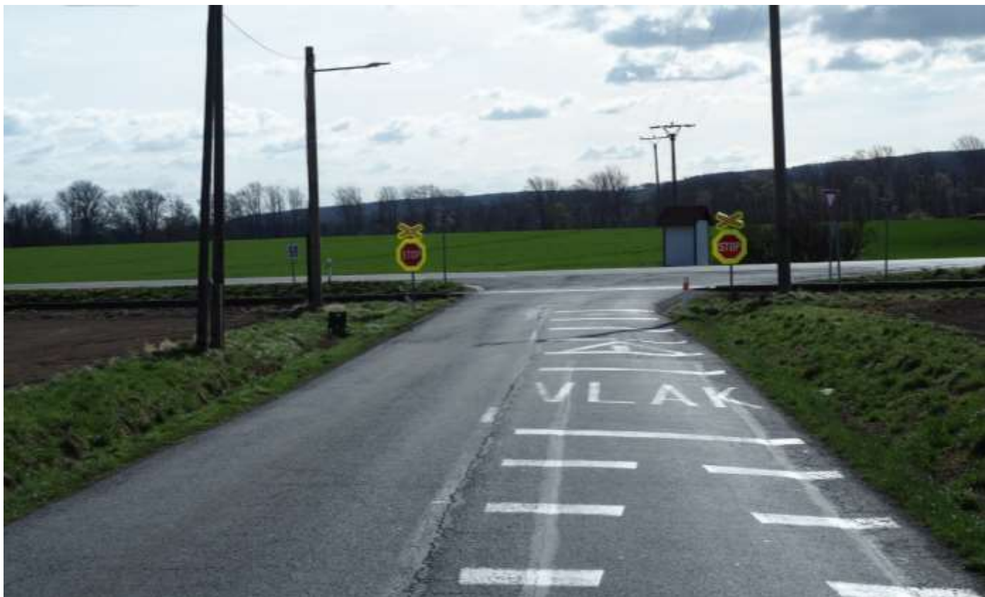
Železniční přejezd P7812 na silnici III/44346 u Otic
