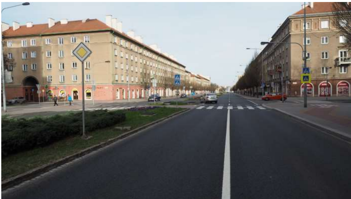
Přechody na silnici I/11 v Havířově
