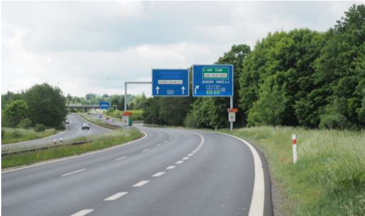
Silnice I/21 u Střížova – portál velkoplošného DZ
