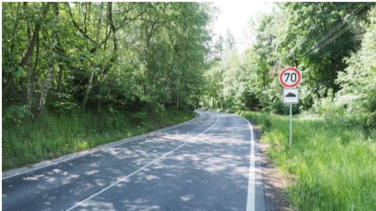
Úsek silnice II/217 u obce Krásná
