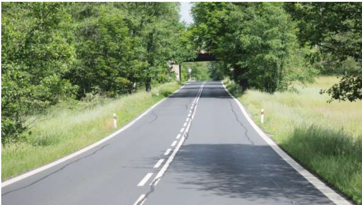
Silnice I/21 u Žirovic – opěry podjezdu a stromy
