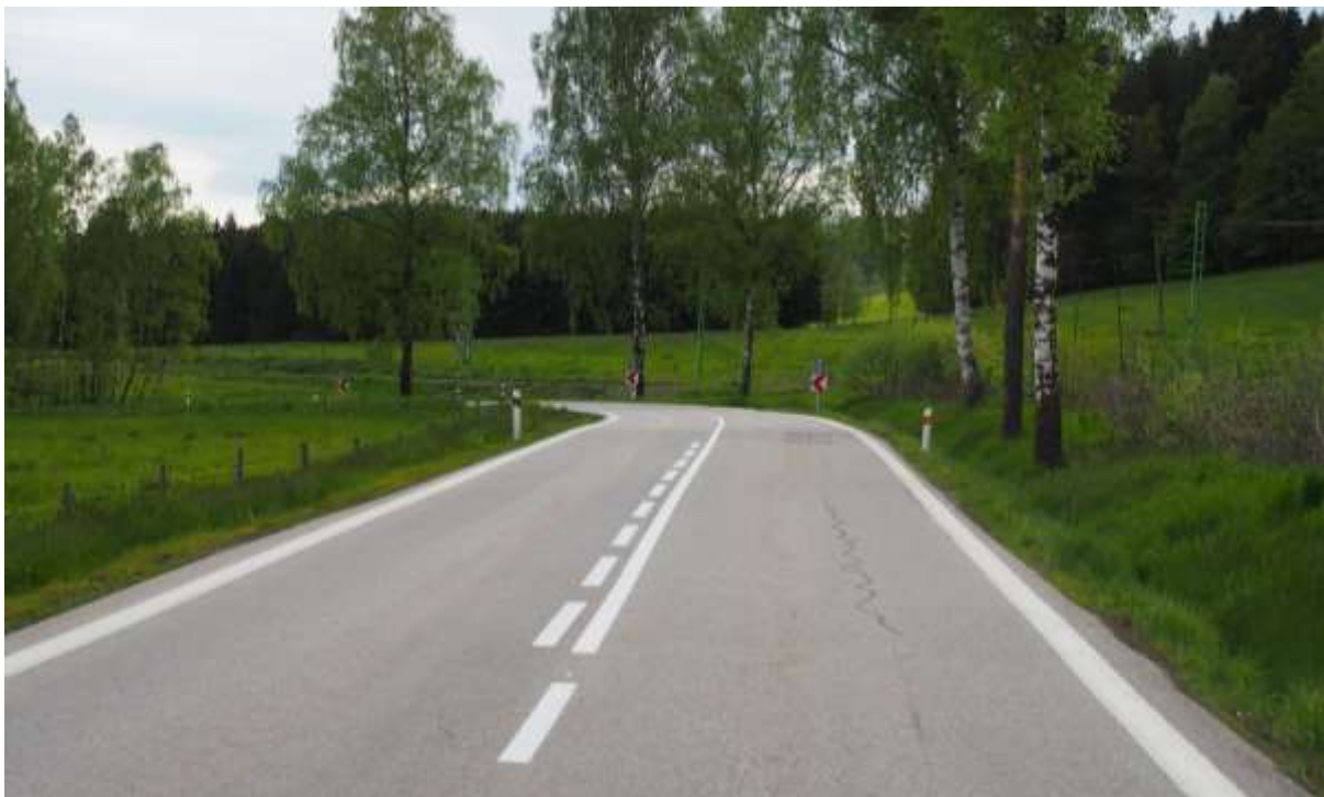
Úsek silnice II/163 u Jenína
