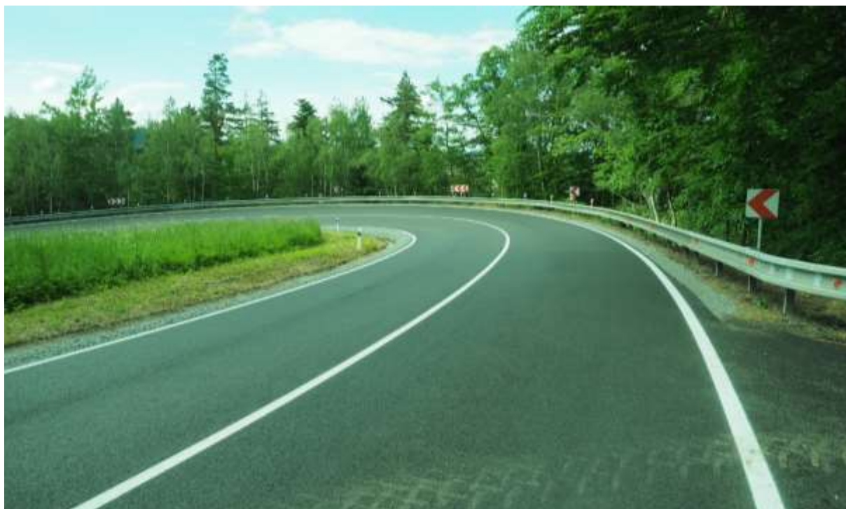
Úsek silnice II/141 u Prachatic
