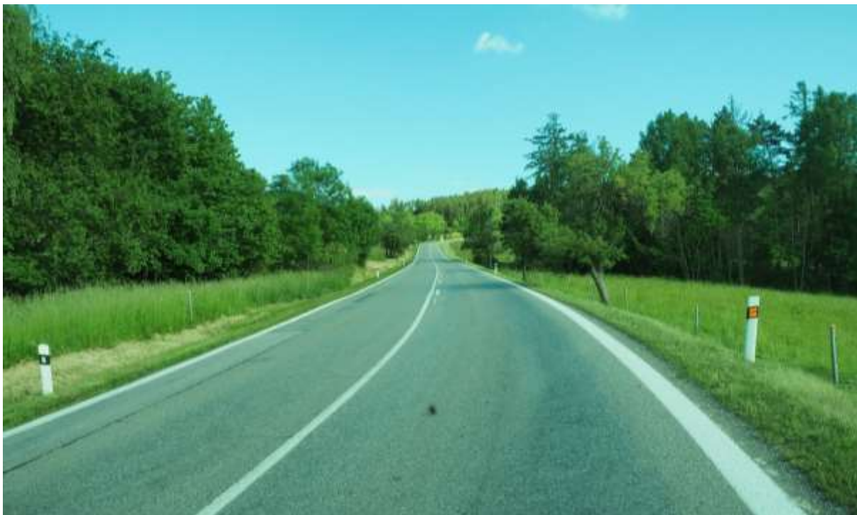
Úsek silnice I/4 u Nišovic
