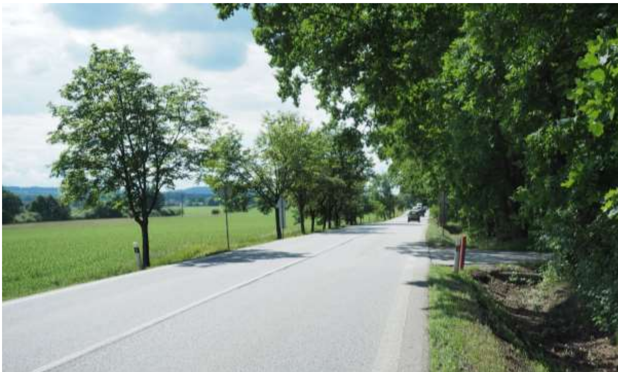
Úsek silnice I/20 u Libějovic
