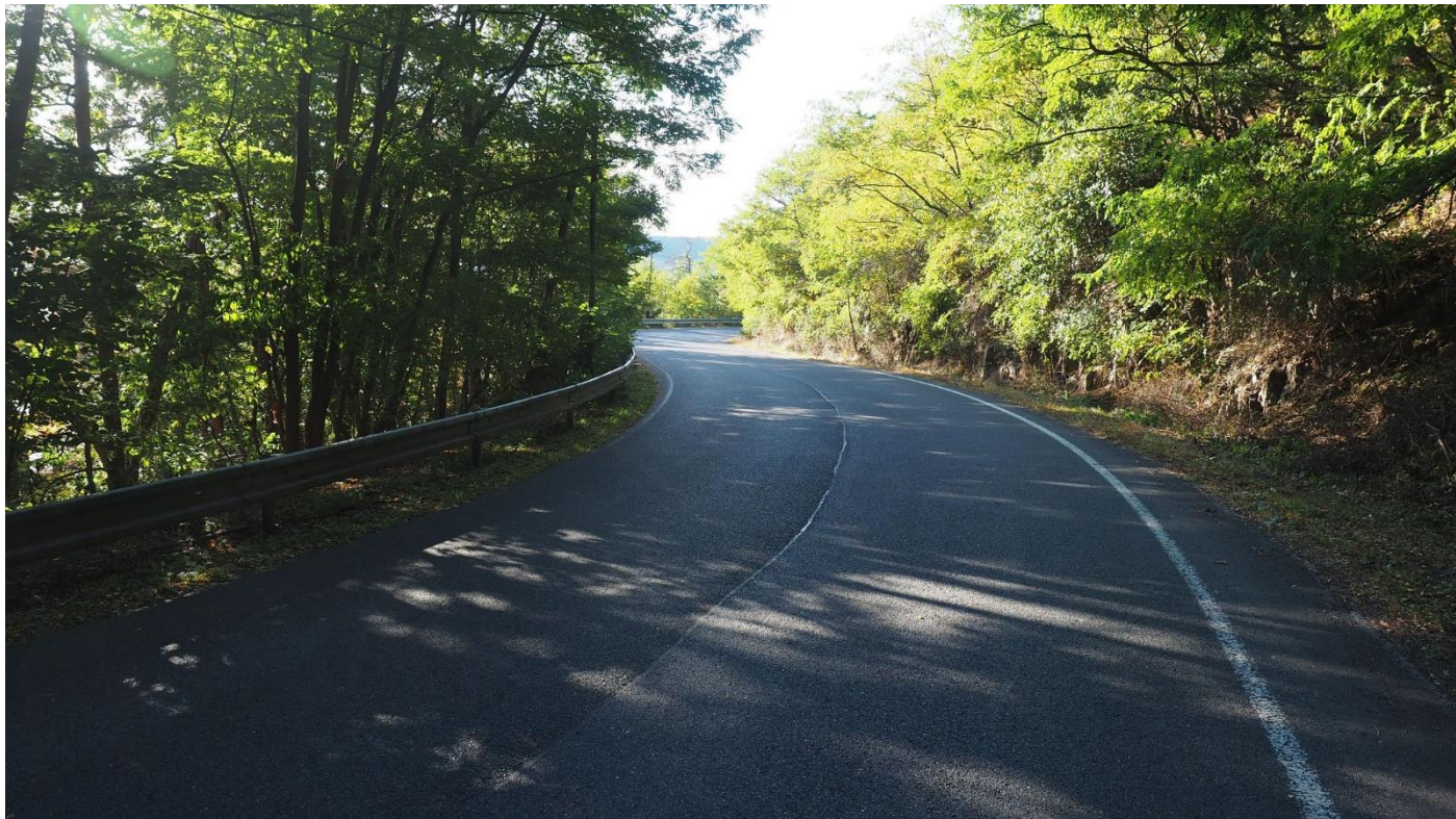
Úsek silnice III/1027 u obce Rabyň – aktuální stav
