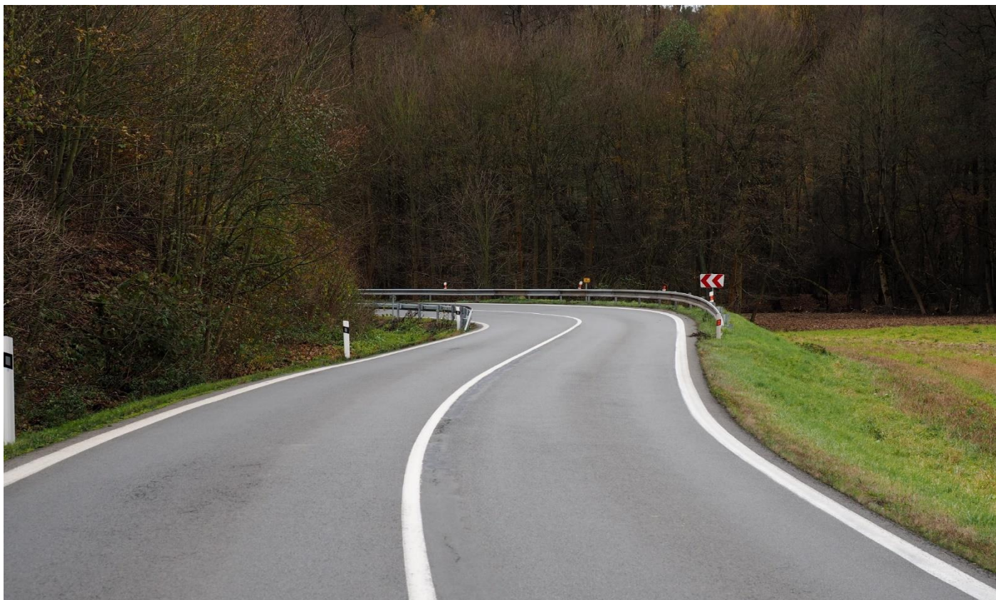
Směrový oblouk na I/9 u obce Tupadly
