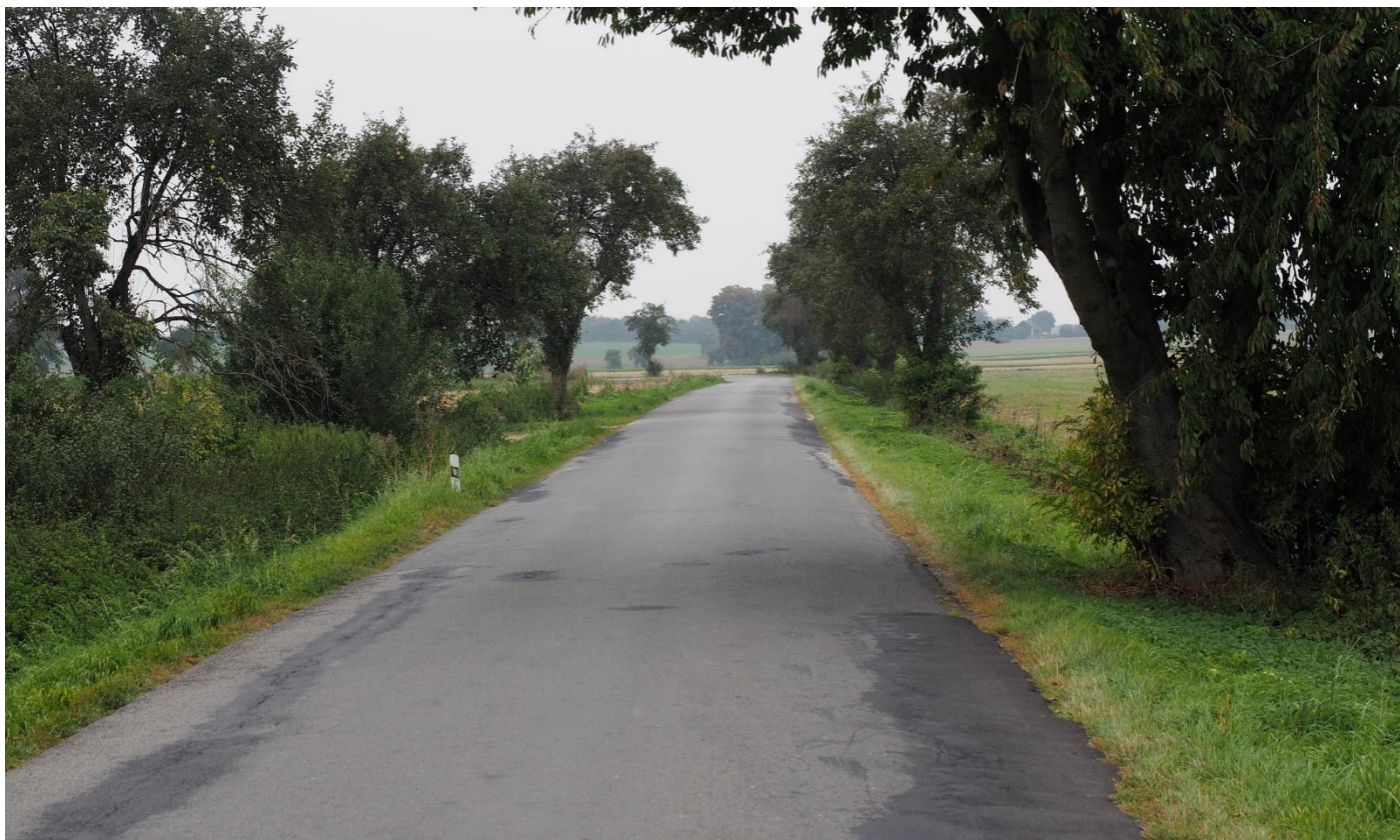
Úsek silnice III/2595 u obce Bukovno
