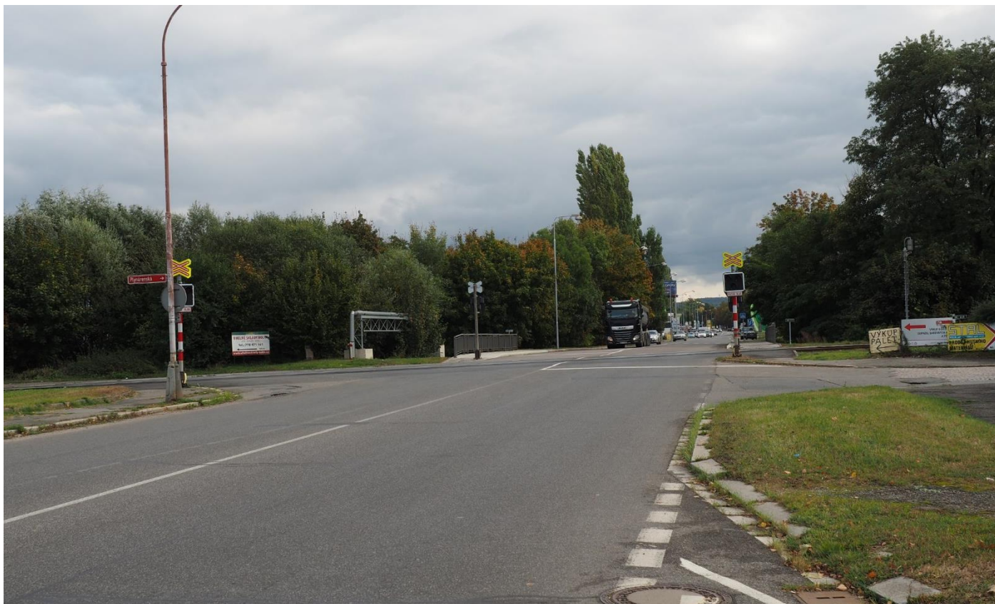
Železniční přejezd P5901 na silnici I/38H v Kolíně
