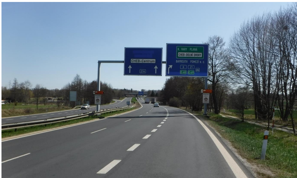
Silnice I/21 u Střížova – portál velkoplošného DZ
