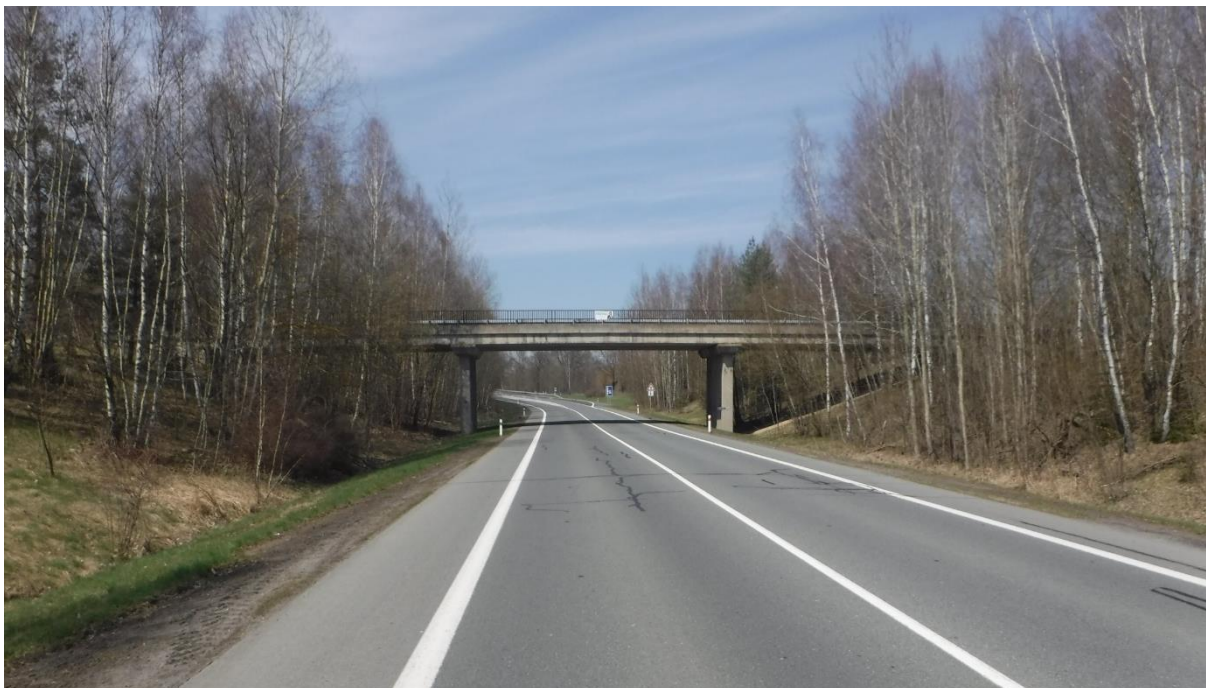
Silnice I/20 u Toužimi – pilíře nadjezdu
