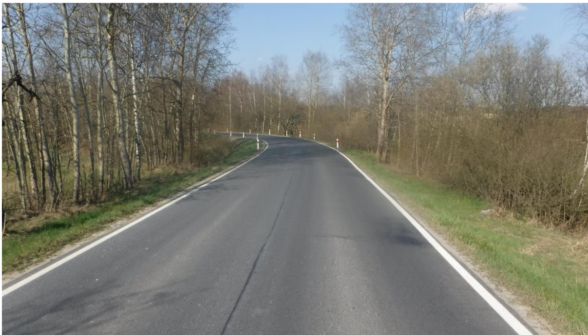
Úsek silnice III/2224 u Jimlíkova
