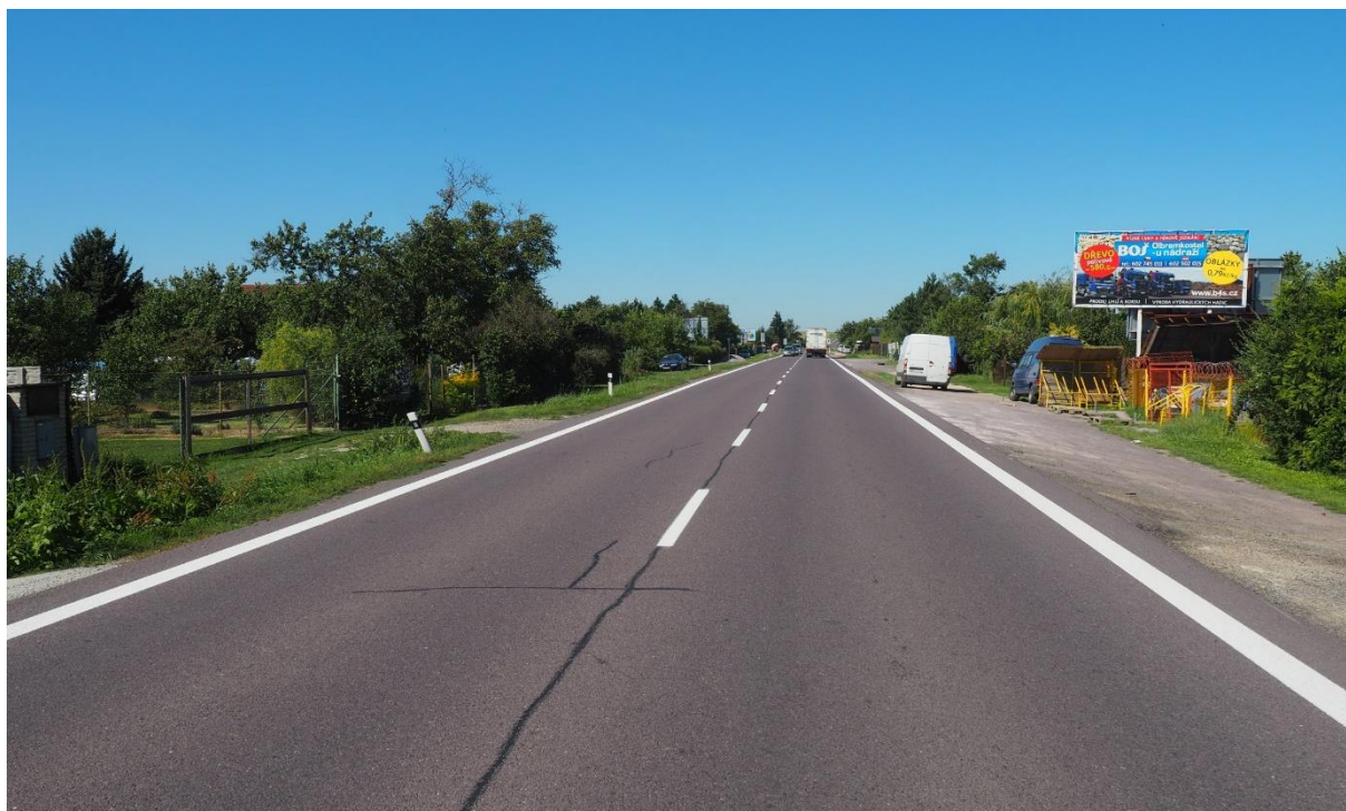
Úsek silnice I/38 na výjezdu ze Znojma
