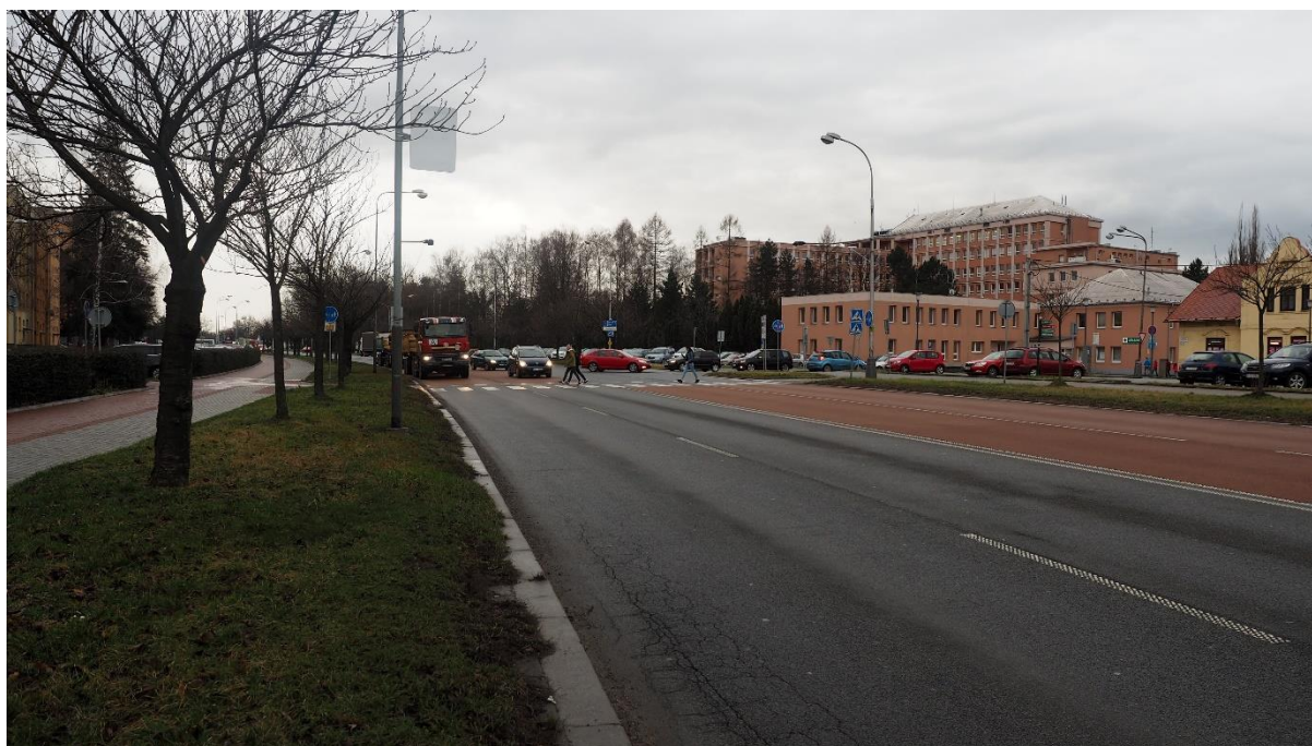
Karviná - přechod pro chodce na silnici I/59
