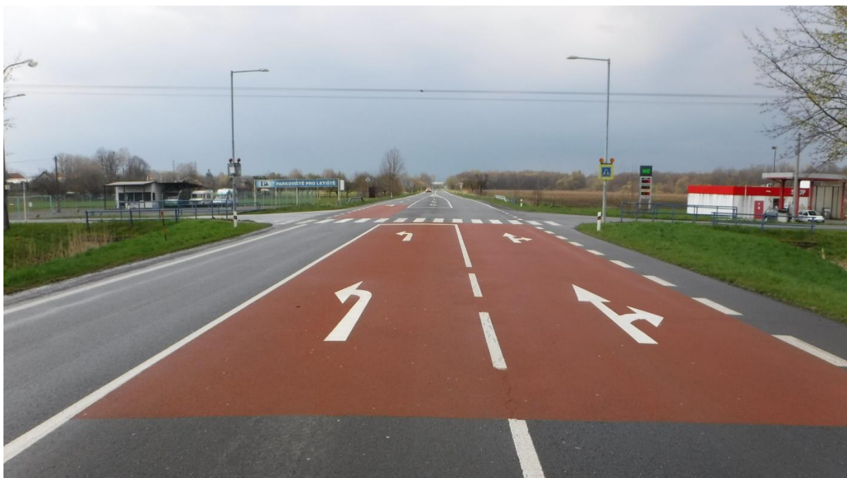
Přechod pro chodce na silnici I/58 na průtahu obcí Skotnice
