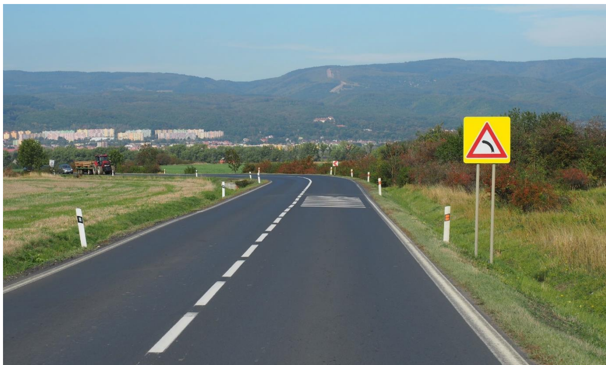
Oblouk na silnici II/251 u Otvic
