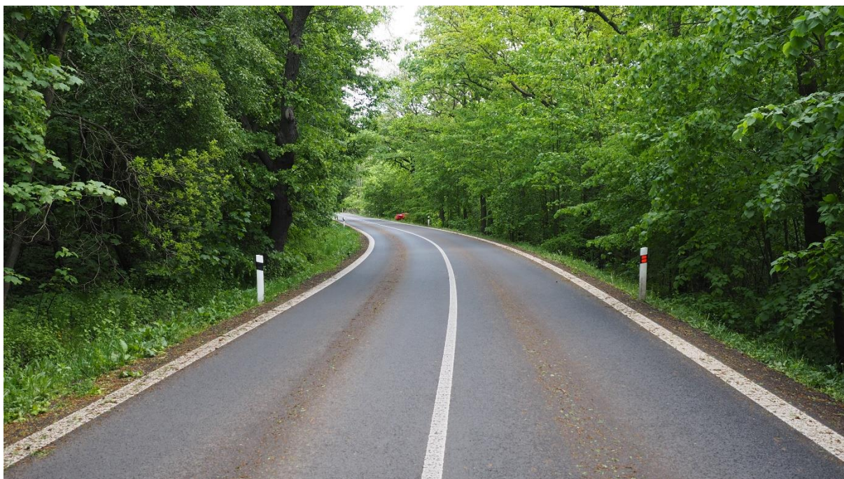
Úsek silnice I/27 u města Osek – aktuální stav
