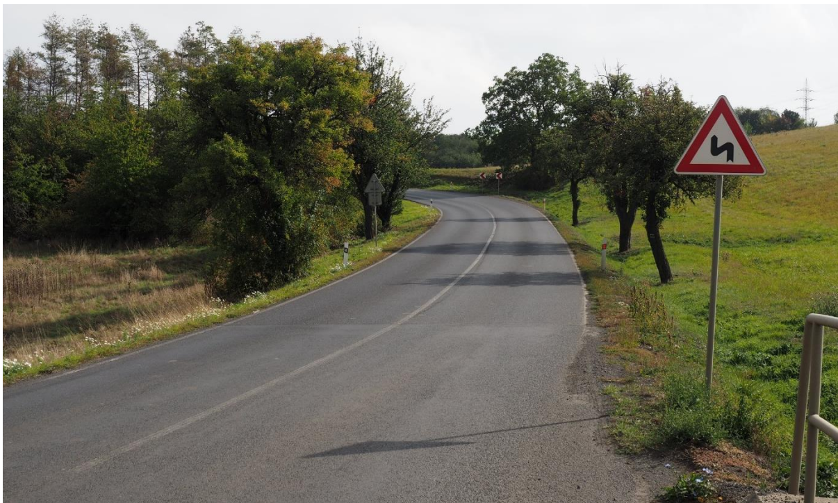
Úsek silnice na II/224 u Kadaně
