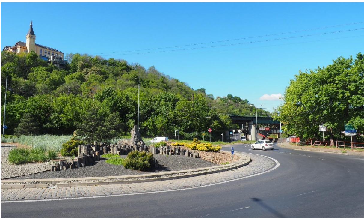
Rizikový příjezd k okružní křižovatce pod Větruší, Ústí nad Labem od silnice I/30.
