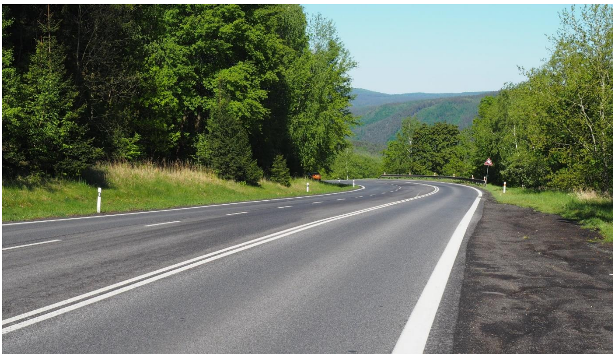
Úsek silnice I/13 Ludvíkovice - Huntířov
