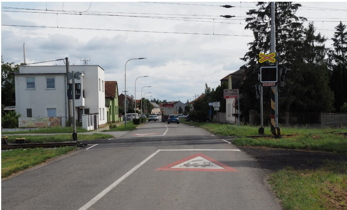
Železniční přejezd P7207 na silnici III/4349 v Chropyni
