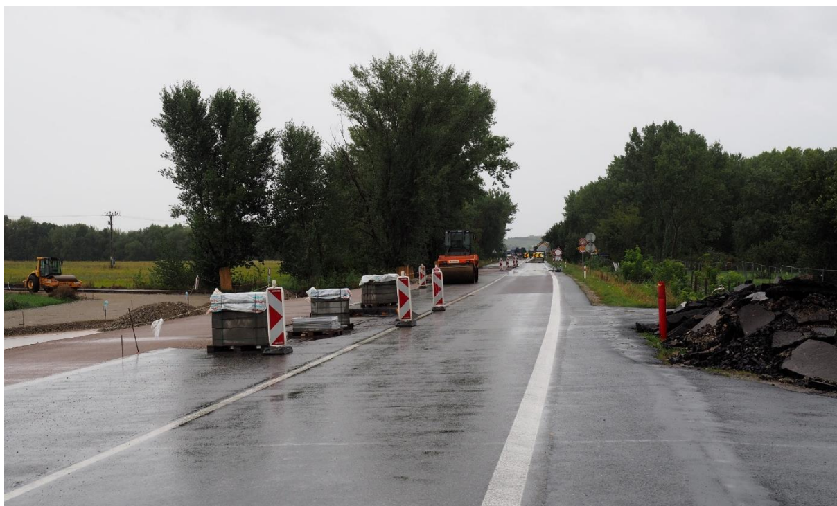
Úsek silnice I/52 „U Rybárny“
