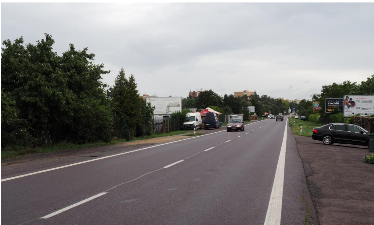
Úsek silnice I/38 na výjezdu ze Znojma
