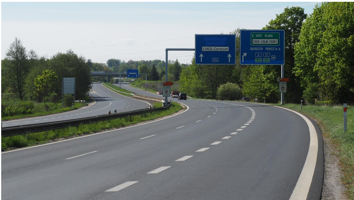
Silnice I/21 u Střížova – portál velkoplošného DZ
