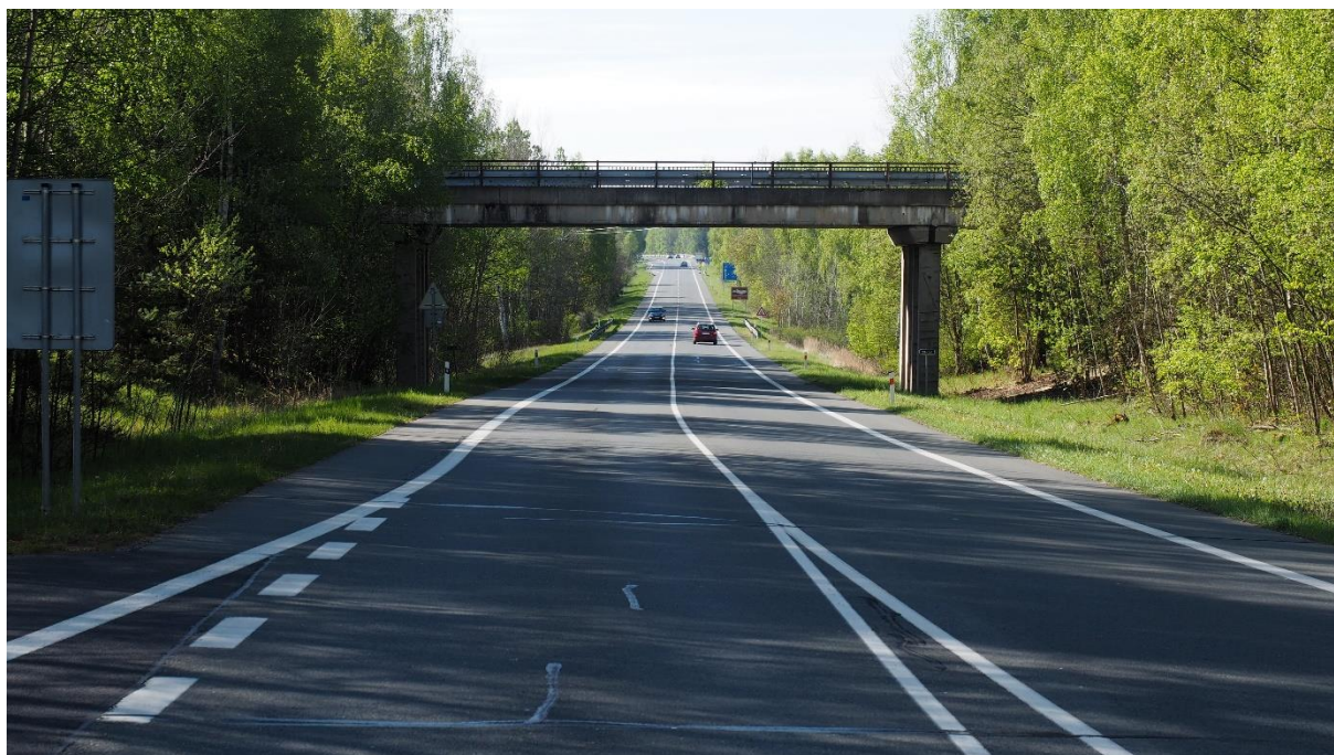
Silnice I/20 u Toužimi – pilíře nadjezdu
