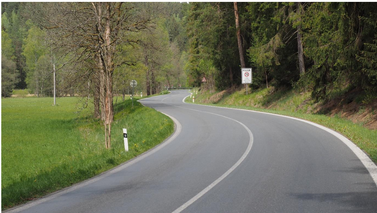
Úsek silnice II/210 u Kraslic
