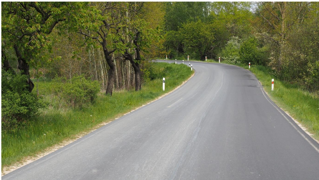
Úsek silnice III/2224 u Jimlíkova
