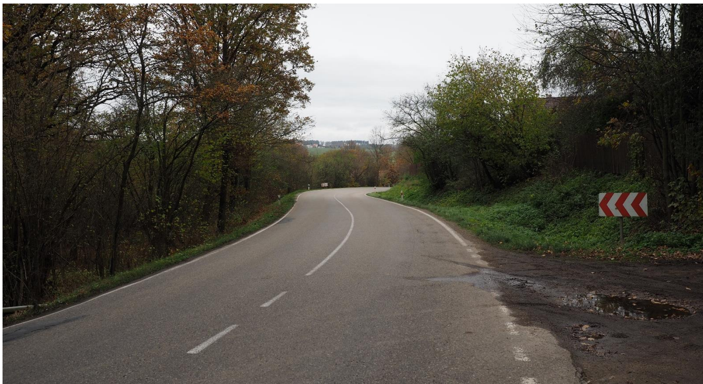
Úsek silnice II/112 u Vlašimi
