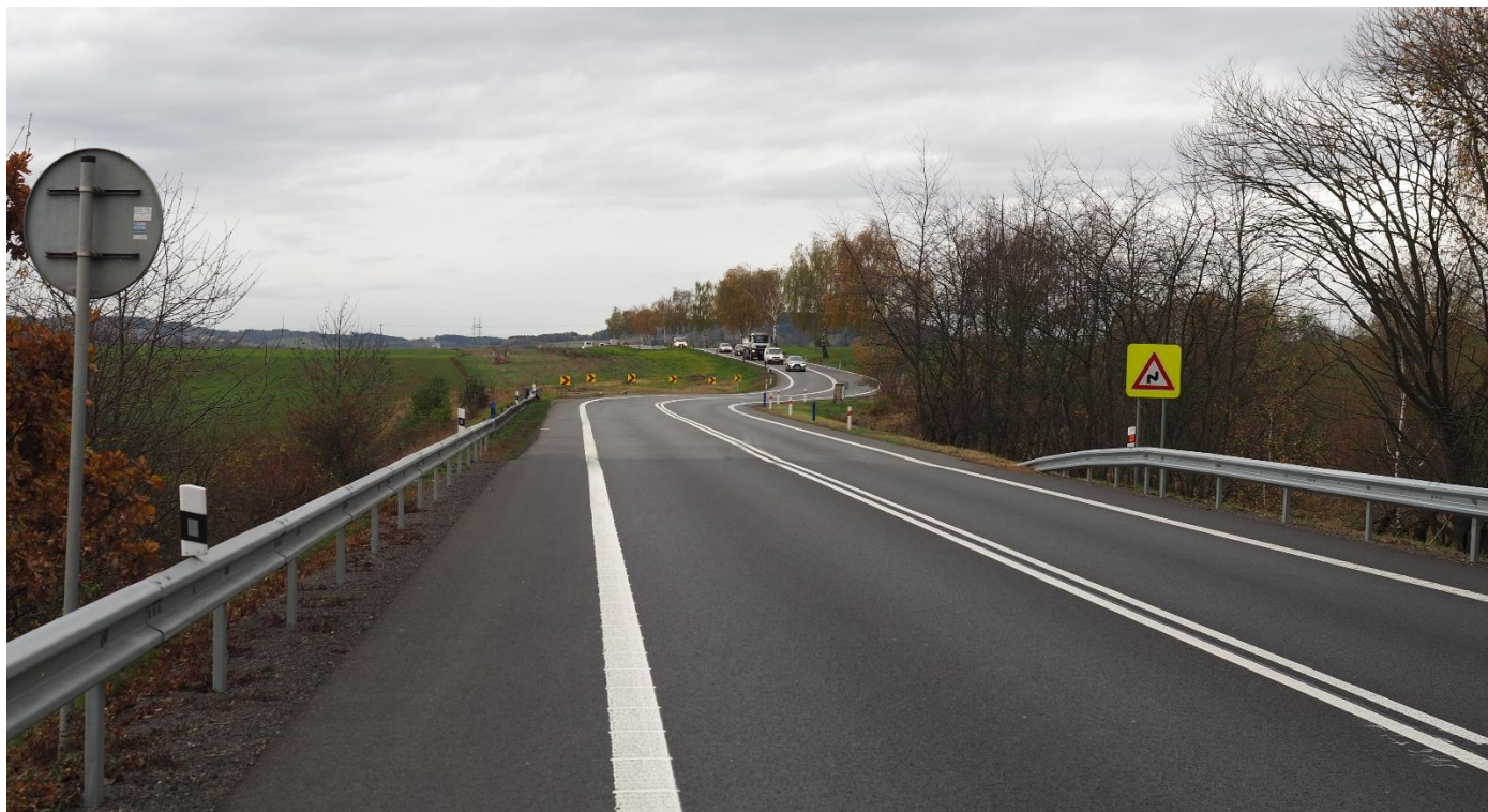
Úsek silnice I/3 u Olbramovic
