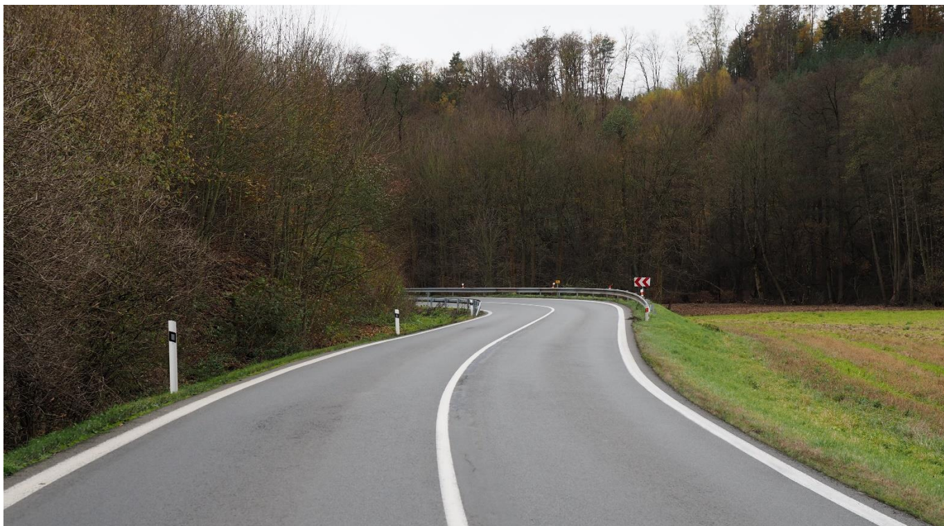
Směrový oblouk na I/9 u obce Tupadly
