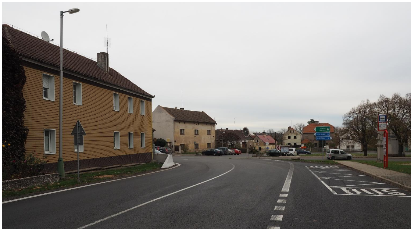
Úsek silnice I/16, Jizerní Vtelno
