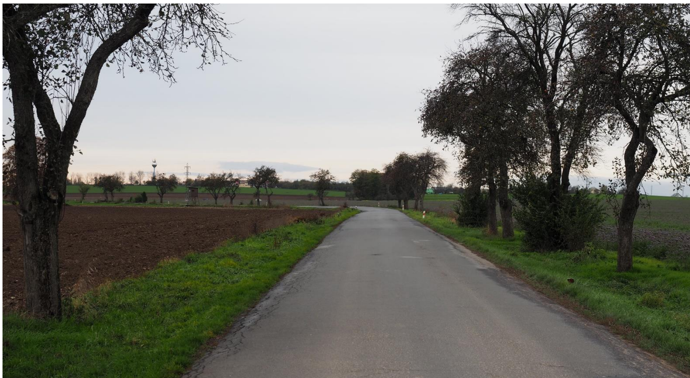
Úsek silnice III/2595 u obce Bukovno
