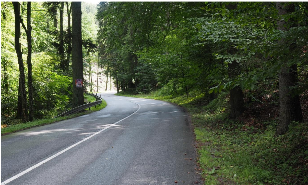
Úsek silnice III/49026 mezi Ludkovicemi a Březůvkami
