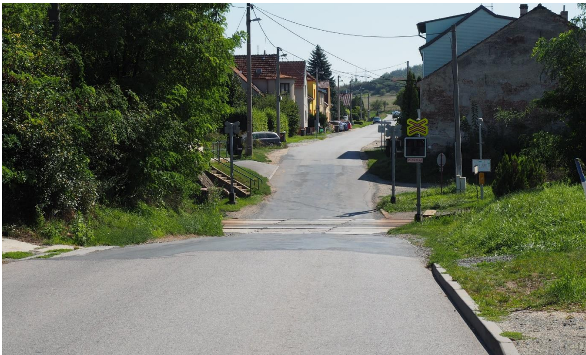
Železniční přejezd P3945 na silnici III/15269 u obce Troubsko
