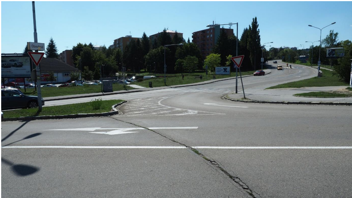
Přechod a křižovatka na II/384 v Bystrci – aktuální stav
