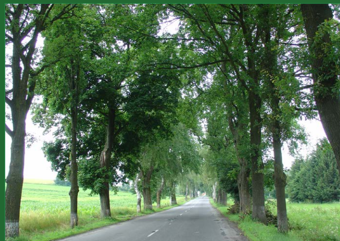
Foto č. 1: Alejí stromů na krajnici je hezká jenom na první pohled. Svodidlo osadit nelze, vysadit nový strom na stejném místě také ne..
