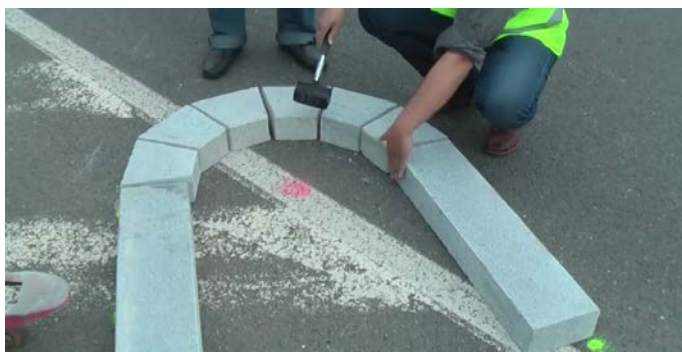
Úprava obrubníku do jeho výsledného tvaru
