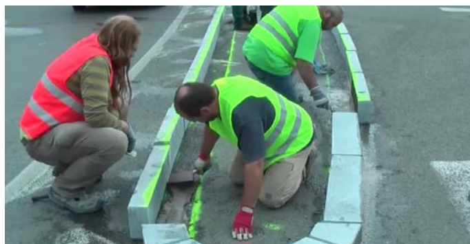
Obrubníky se vykopí kolem vnější hrany, položí se lepicí tmel pod budoucí polohu obrubníku a ten se přiloží do výsledného tvaru.
