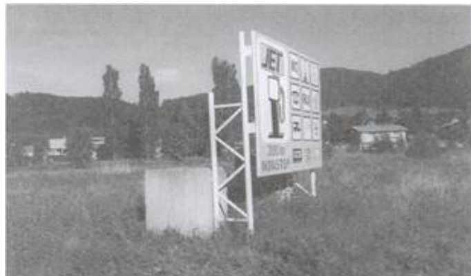
Obr. 4 Nevhodná nosná konstrukce reklamního poutače. Pevnou překážkou může být např. i plot.
