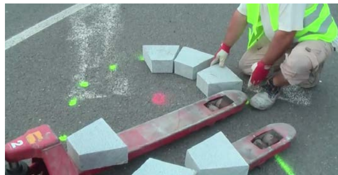
Příprava k lepení obrubníku na stávající vozovku
