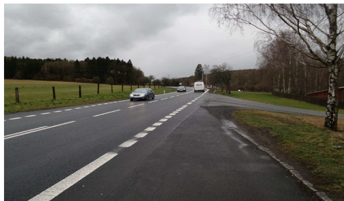
Obr. 5 Celkem vhodná konstrukce plotu.
