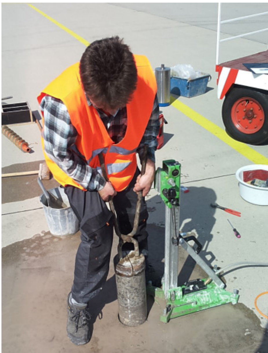
Vyjmutí jádrového vývrtu
