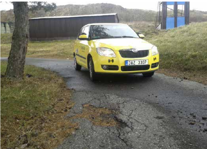
Nerovnost na silnici nižší třídy, která se často může vyskytovat i na frekventovanější silnici a lehce může vyvolat smyk zadní nápravy obzvláště pak, je-li na vozovce námraza.
