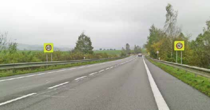
Příklad odůvodněného snížení rychlosti v extravilánu ve vztahu k návrhovým prvkům navazujícího směrového oblouku.
