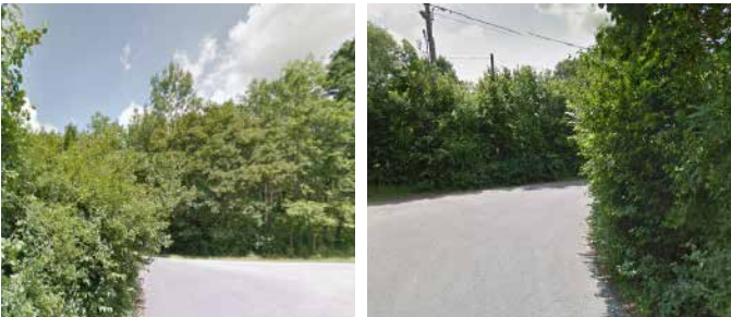
Nedostatečné rozhledové poměry – Chobot u Vysokého Mýta
