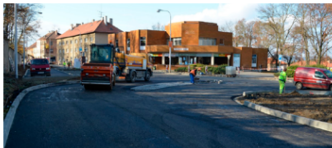
Těsně před dokončením stavby (listopad 2016)
