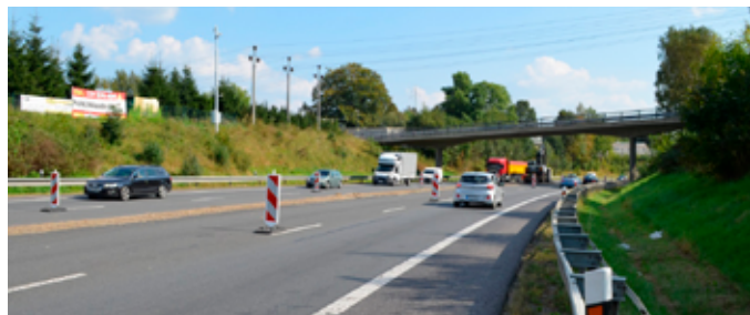
Probíhající výměna středových svodidel (září 2016)
