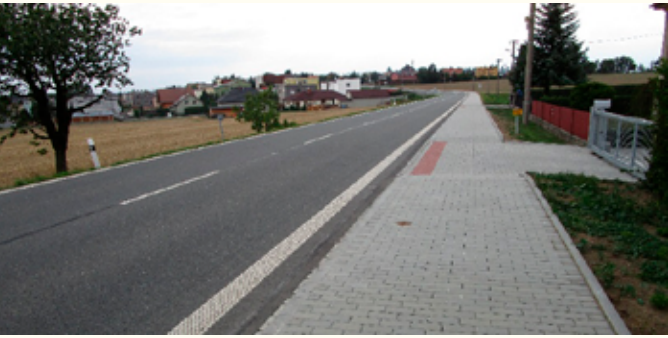
Výstavba chodníku podél silnice I/46, Služovice
