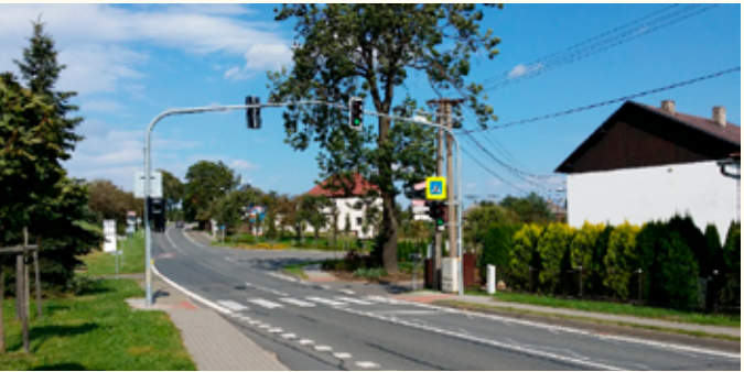
Modernizace dopravního značení na sil. I/46 v obci Rohov
