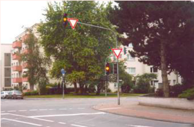
Dopravní značení na výložnících (Německo, 2001)
