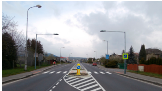
Obr. 6: Vytvoření dělicího ostrůvku v místě dlouhého přechodu pro chodce
