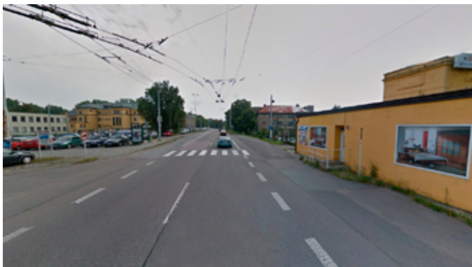
Obr. 3: Rizikové uspořádání přístupu na přechod pro chodce
